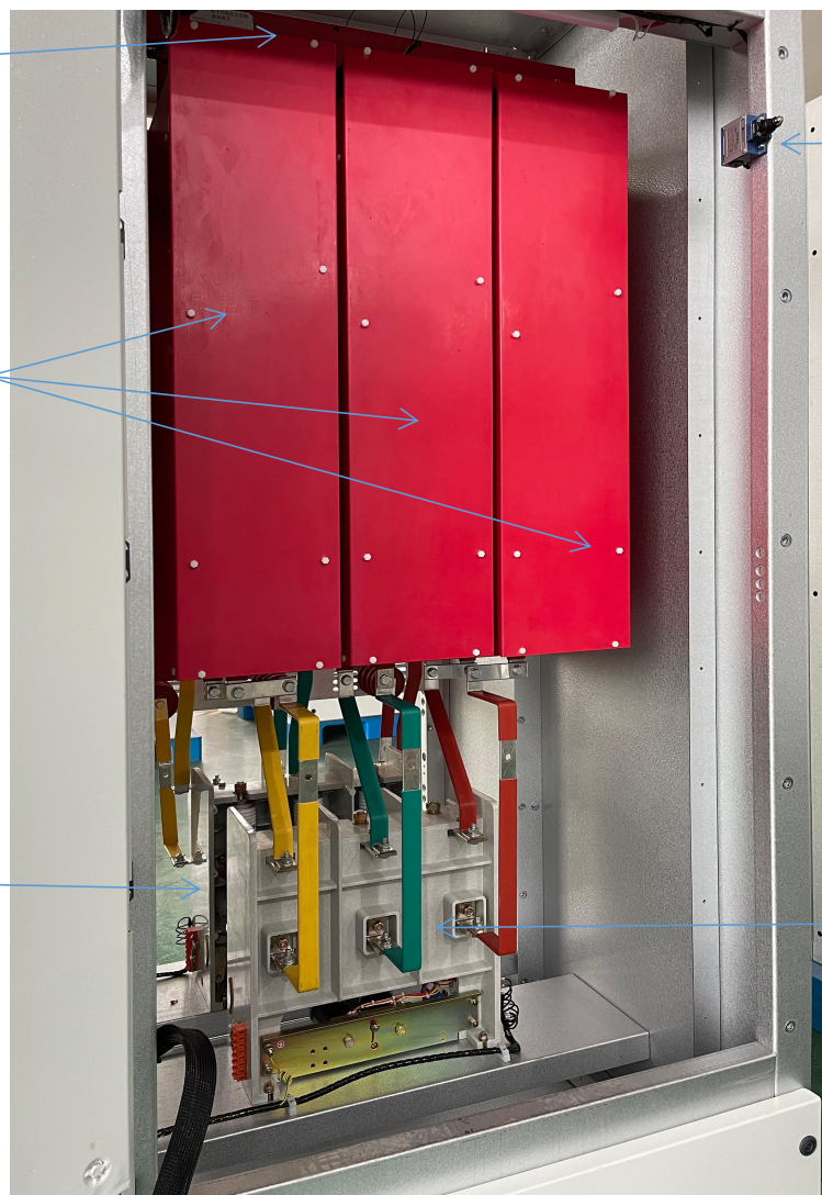
图四、MDMVS中高压固态软起动柜高压舱室
